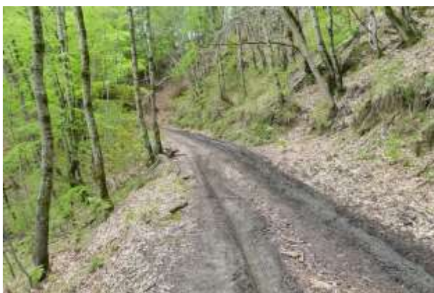
Foto 9 – strada forestale che attraversa la particella forestale
